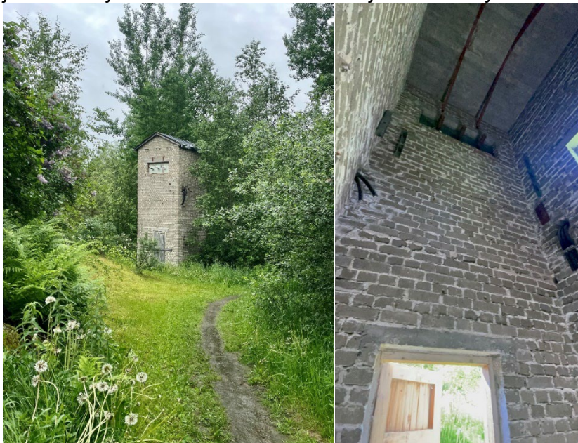
Tornimuuntamorakennus ulkoa ja sisältä kuvattuna.
